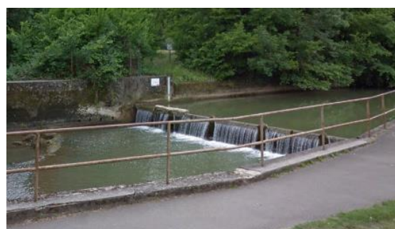
Seuil sur l'Ouche à Dijon (ROE17521).
