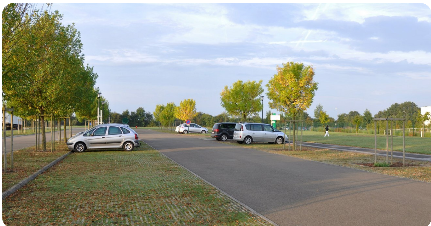
▲ Parc d'activités Ouest Park à mi chemin entre Sablé-sur-Sarthe et La Flèche (72). Source : Atlas des Paysages Pays de la Loire
